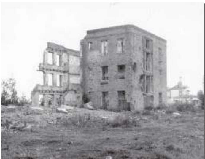
Разрушенное здание школы № 2 Павловска 4
