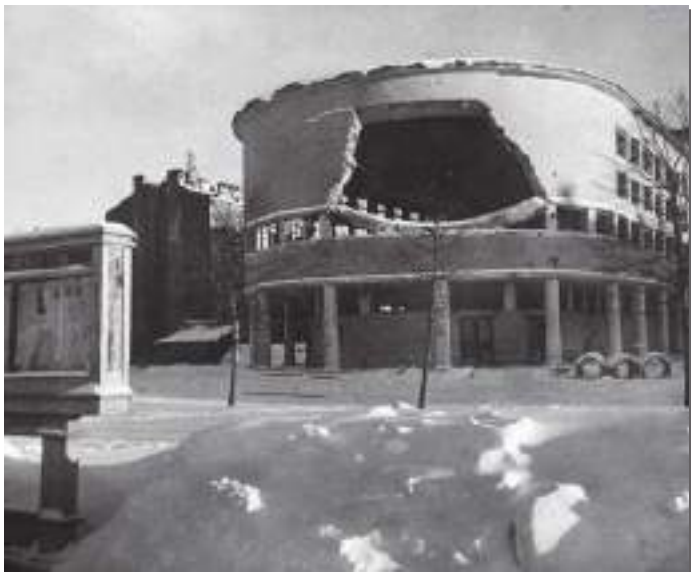
Разрушенное здание школы № 52 Кировского р-на 2
